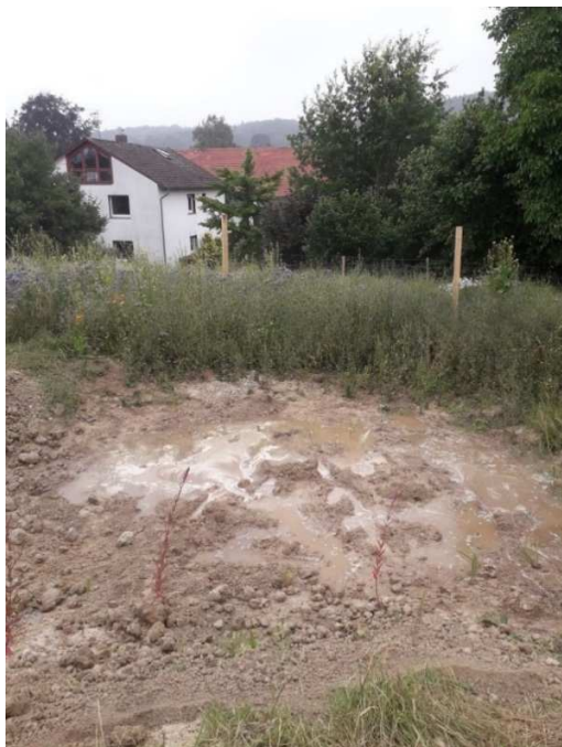
Abbildung 8: Erstes Wasser wird eingeleitet
