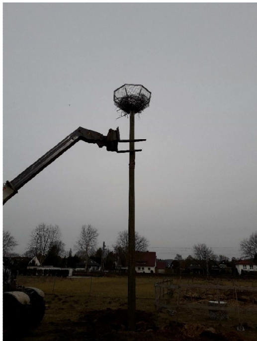
Abbildung 21: Errichtung eines der Storchenmasten
