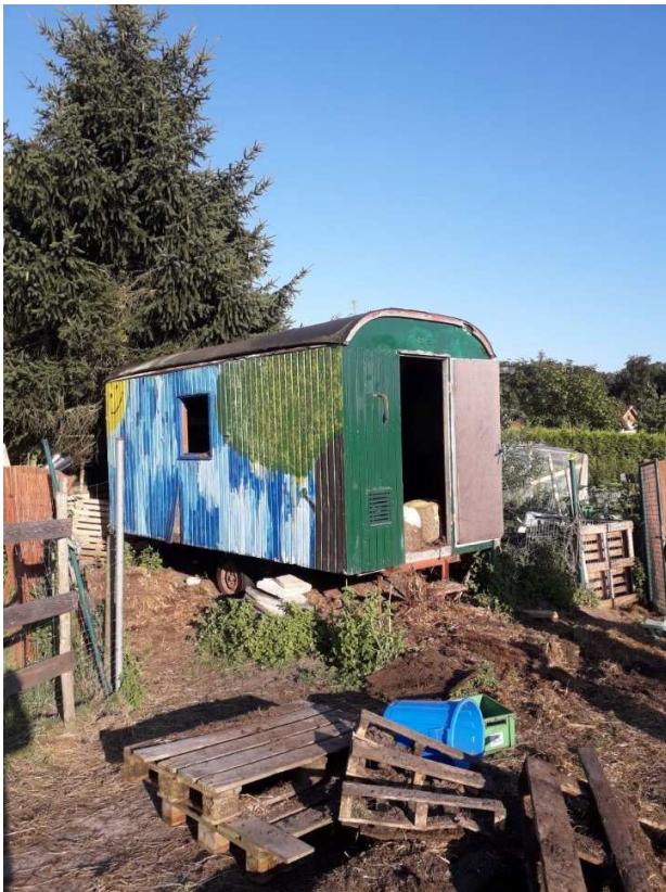
Abbildung 22: Schaf- und Ziegenstall während des Aufbaus
