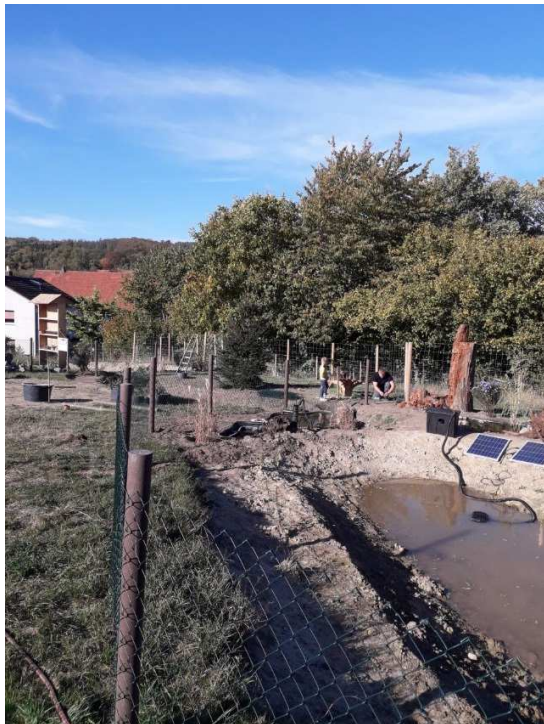
Abbildung 15: Wassertransport durch Solarpumpen
