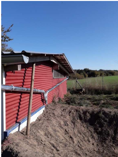
Abbildung 14: Gestaltung des Wasserzulaufs („Himmelsteiche“):
